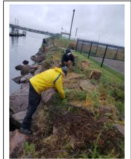
Ajout de paille au mur de roche
