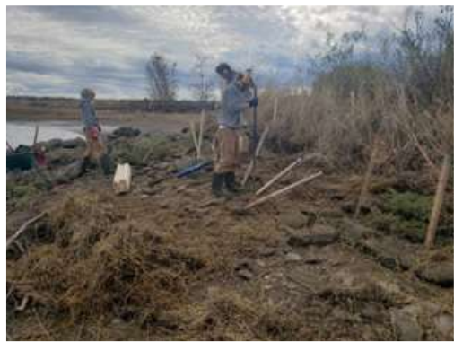
Réparer la brèche dans la clôture
